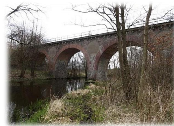
Wiadukt na Redze w Prusinowie (fot. Internet)
